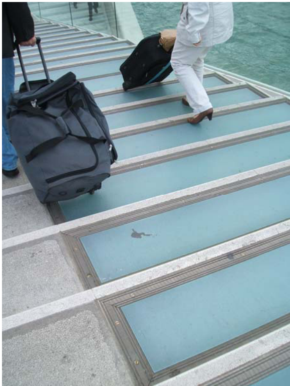
Fig. 3. Ponte della Costituzione: detail
